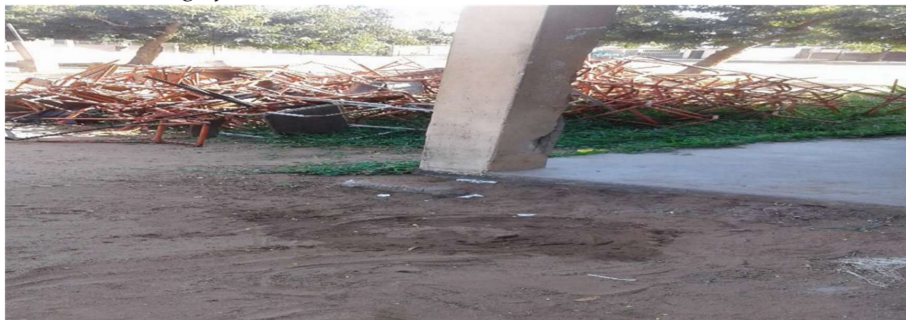
Fotografia 5: Jardim da Escola Secundária da Machava-Sede
