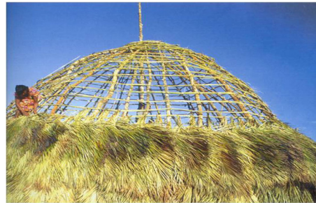
Figura 2 - Construção de Abrigos.
