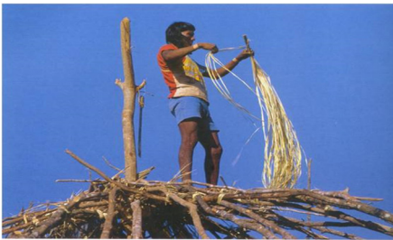
Figura 1 - Construção de Abrigos.
