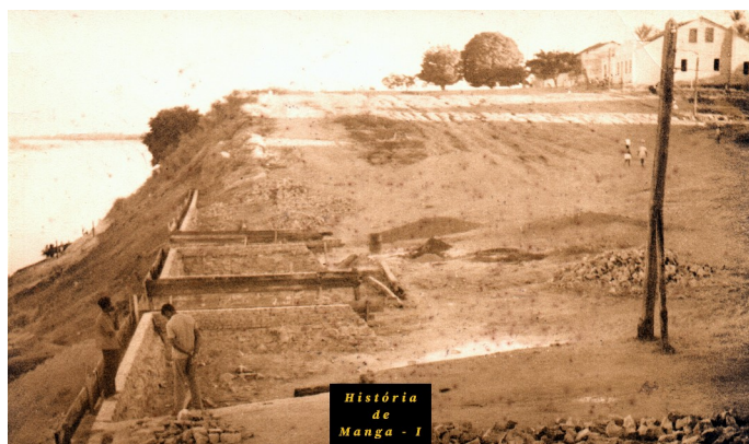
Figura 22: Construção do Cais. Fonte: domínio público.
