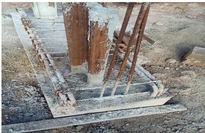
Figura 1: Trilhos Ferroviários cravados como estacas de fundação.
