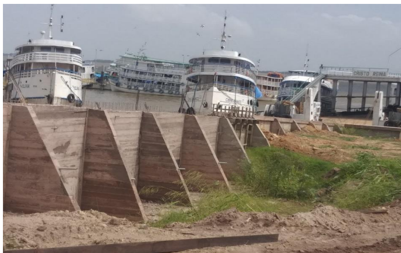
Figura 8: Contrafortes finalizados com furo de passagem para as barras do tirante.
