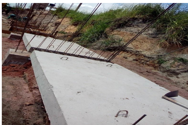
Figura 4: Placas de fundo do muro posicionadas sobre os blocos de coroamento.
