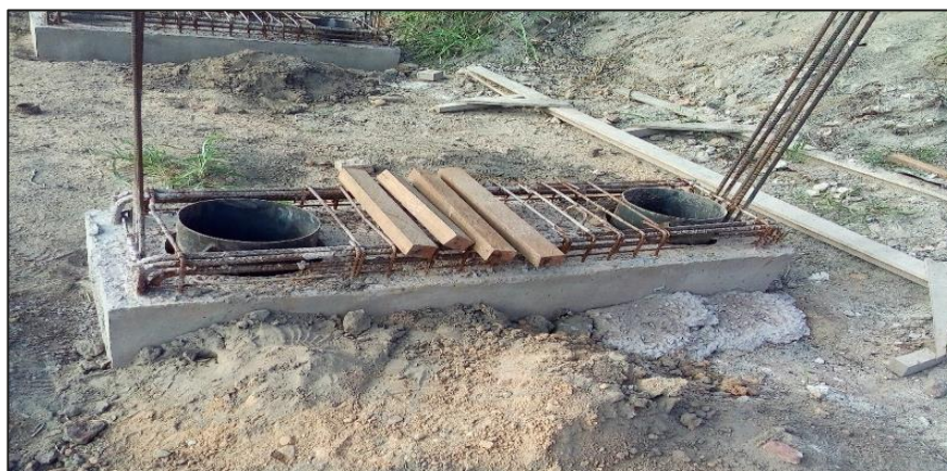
Figura 3: Imagem real do bloco de coroamento já alocado em seu destino final.
