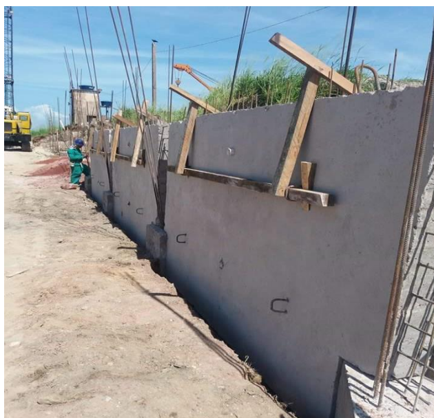
Figura 5: Posicionamento das placas verticais do muro.
